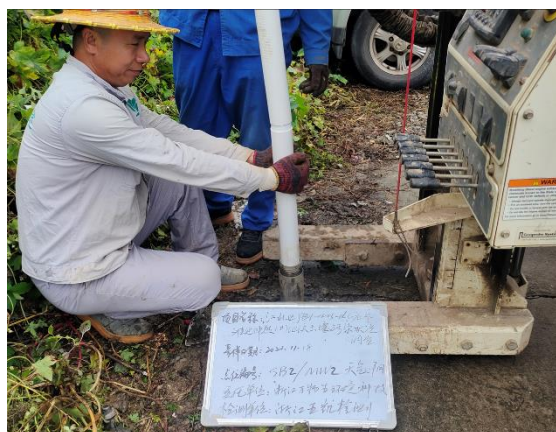
安装地下水监测井
